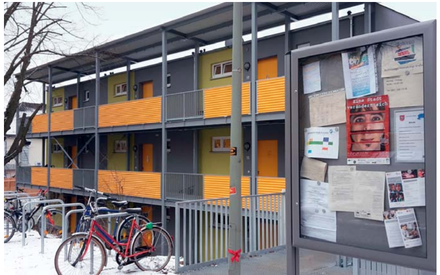
Die Wohnanlage in der Hannah-Vogt-Straße 10, eine von zwei Einrichtungen zur Unterbringung von Flüchtlingen, die von Bonveno betreut werden.
