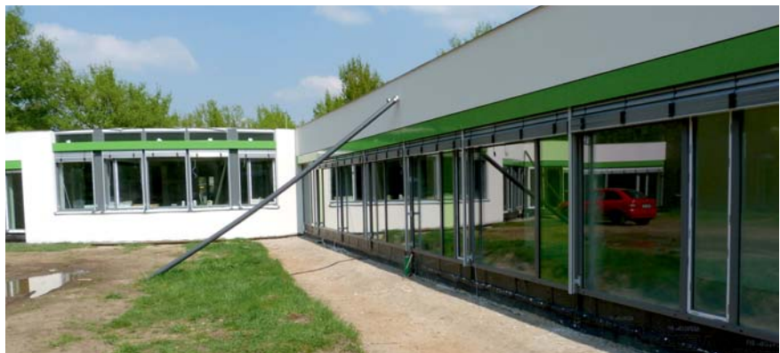
Die Bauarbeiten schreiten zügig voran: Ende September 2014 soll das Aegidius-Haus Auf der Bult eröffnet werden.
