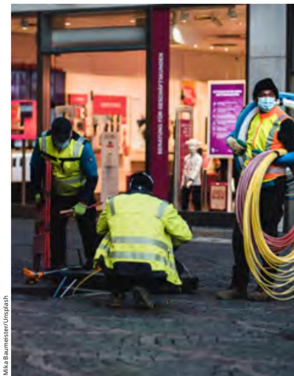
„Schnelle Datenleitungen bis ins letzte Dorf“: Arbeiter verlegen hohle Kabelleitungen für Glasfaserverbindungen.
